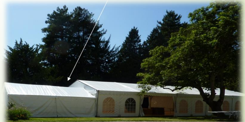
Structure alu 10m avec tente traiteur 5x8 juxtaposée à la structure.
